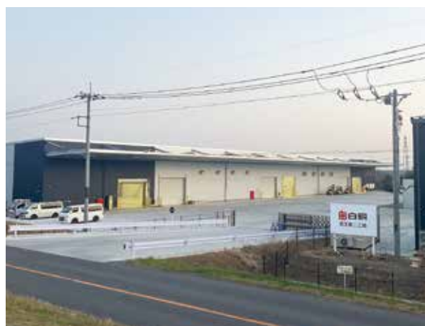
▲新設された埼玉第二工場の外観
